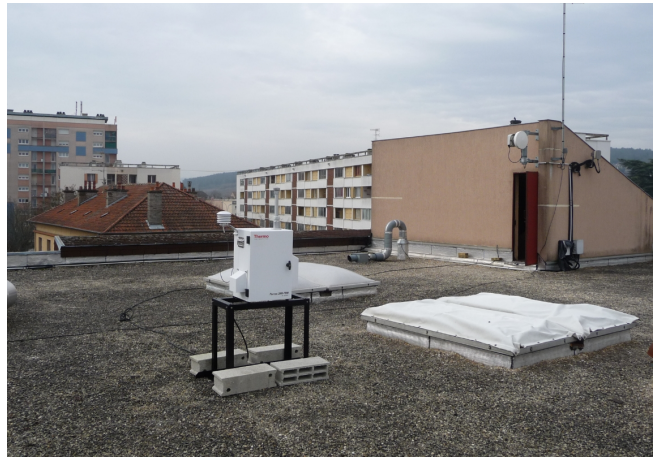
Préleveur sur le toit de la Mairie
